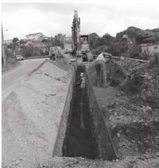
Obras no interceptor de Covelas estão interrompidas
